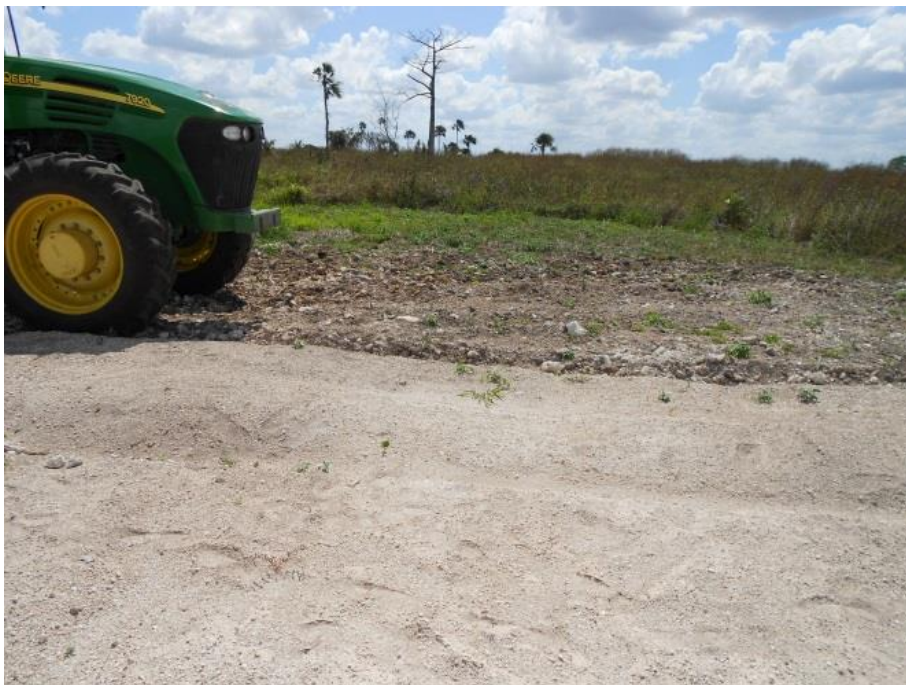
Antes y después de la trituración de piedra
