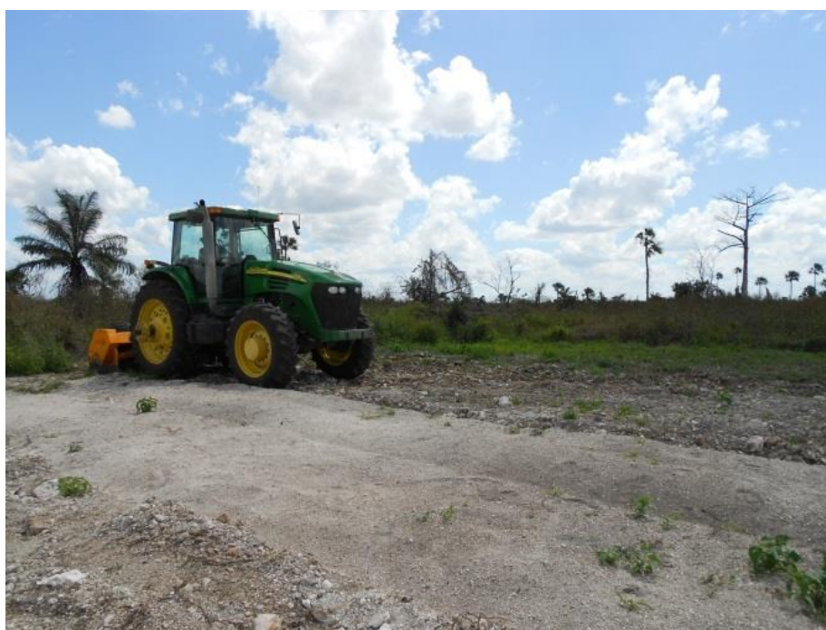
Trabajos de recuperación de suelos
