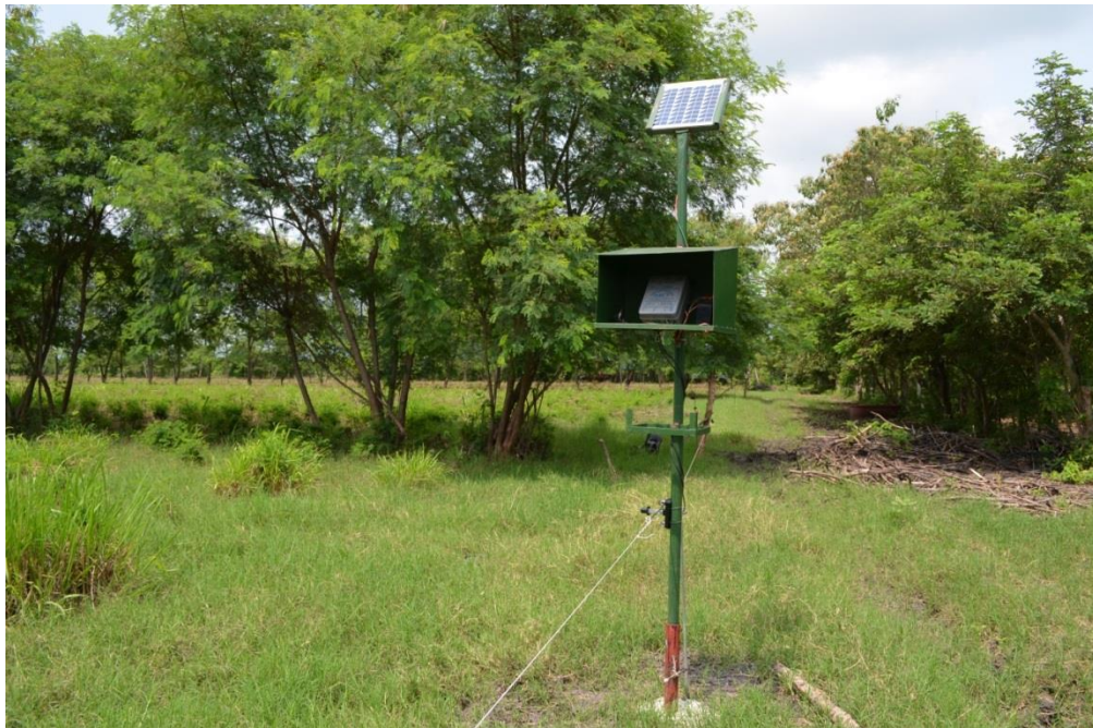
Los cercos eléctricos son un elemento indispensable del SSI.
